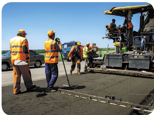
Ремонт дорожнього полотна
