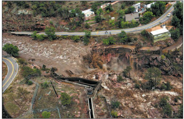
Мал. 5. Повінь. Негативні наслідки повеней: затоплення полів, доріг, виробничих і житлових споруд.
