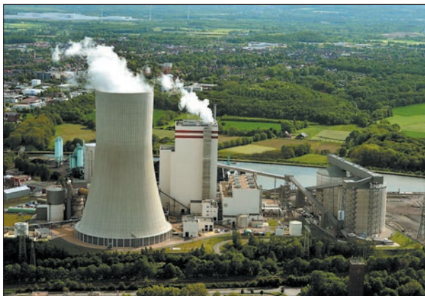
Мал. 2. Вугільна ТЕС у Німеччині. Країна має значні запаси кам'яного та бурого вугілля, тому багато ТЕС працюють на цих видах палива. Уряд країни постійно підвищує вимоги до їхньої екологічної безпеки. У 2013 р. в Німеччині ввели в експлуатацію найбільш ефективну й екологічно чисту вугільну електростанцію в Європі з коефіцієнтом корисної дії в 46%.
