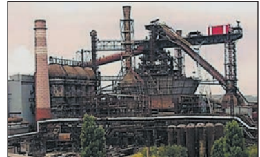
Мал. 3. Металургійний комбінат «Арселор Міттал Кривий Ріг». Підприємства, для яких характерне комбінування різних виробництв, часто називають комбінатами. На них продукція одного виробництва стає сировиною або матеріалом для іншого. Так, до складу металургійного комбінату «Арселор Міттал Кривий Ріг» входять коксохімічне, гірничодобувне і металургійне виробництва.
