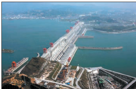
Мал. 4. ГЕС «Сан-Ся» (Китай). Довжина греблі ГЕС становить 2309 м, висота — 185 м, тому іноді її навіть порівнюють із Великою Китайською стіною. Будівництво ГЕС тривало понад 15 років. Зараз вона не тільки виробляє електроенергію, а й використовується для регулювання річкового стоку, зрошення та водозабезпечення.
